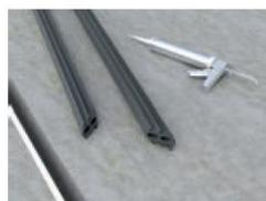
Para crear un empalme se realiza un corte biselado de 45° en ambos perfiles.
